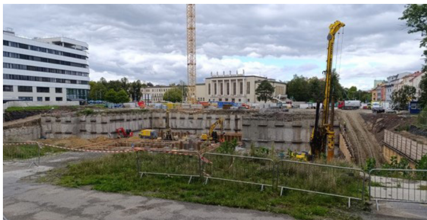
Obr. 15. Stavba Černé kostky – podzim 2025 (Zdroj: archiv MSVK)
