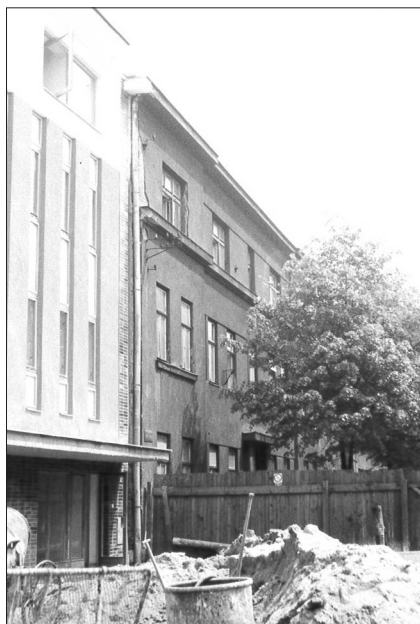
Zahájení stavby druhé budovy skladu na Macharově ulici, 1978
